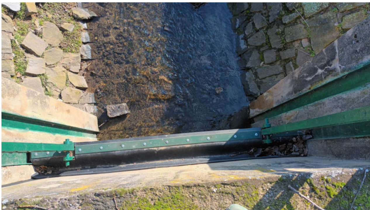
Anšovský potok – vodící ocelové U-profilý pro stavidlo a provizorní hrazení
